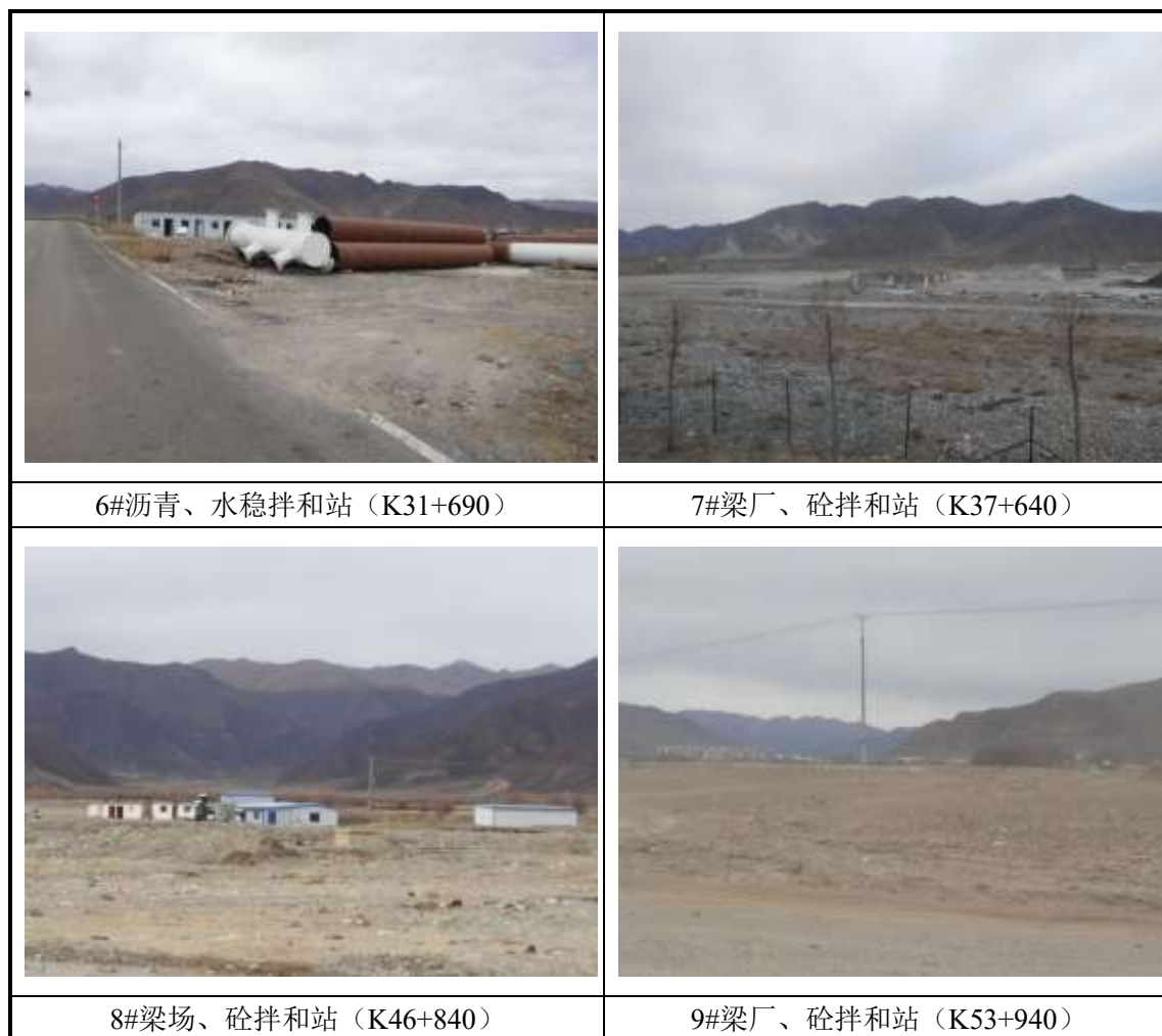
图 5.2-3 施工场地用地恢复情况
