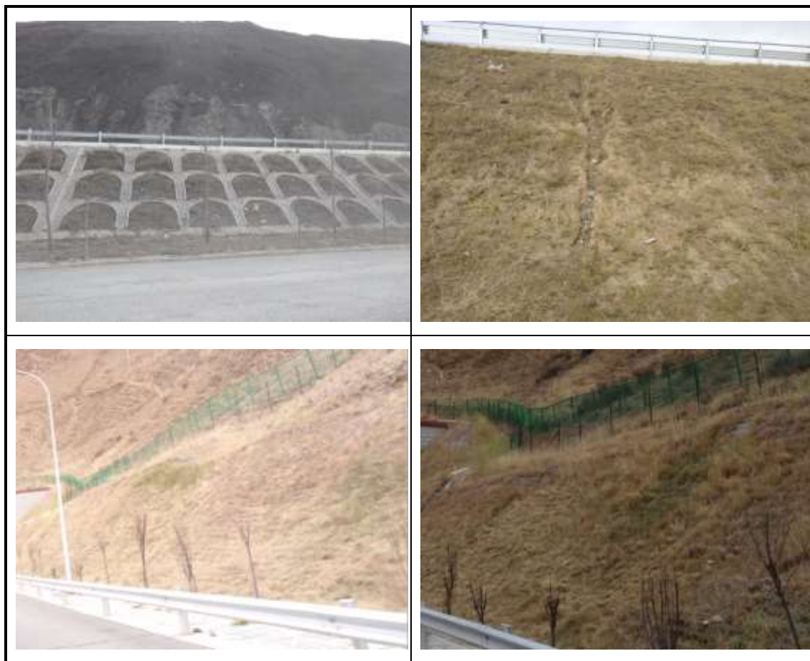
图 5.3-6 公路沿线边坡绿化
