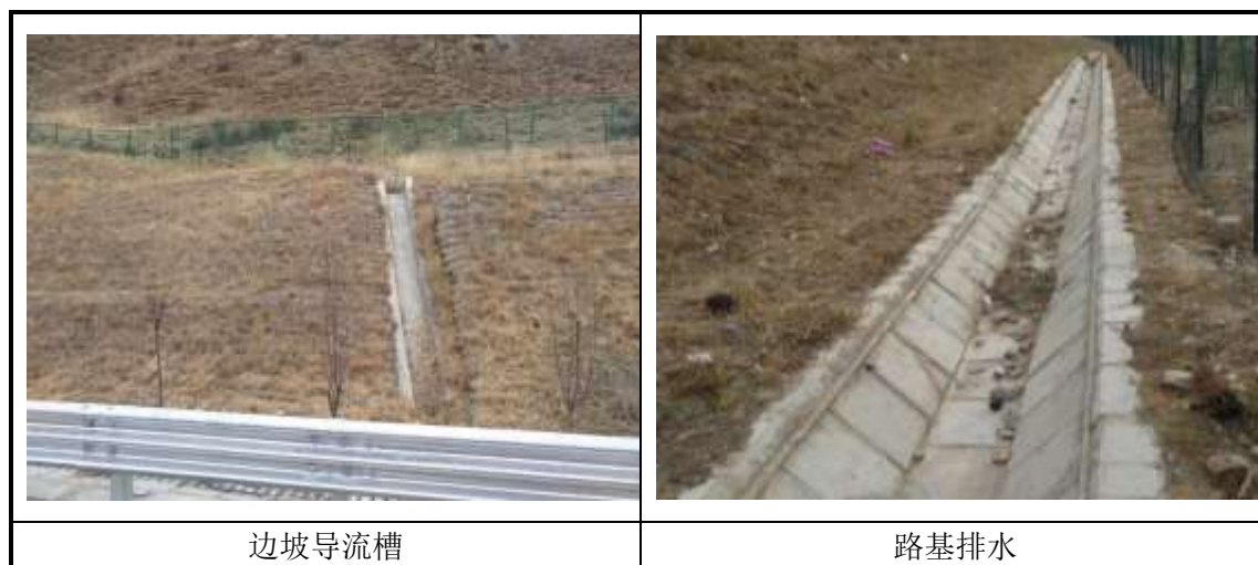
图 5.4-1 沿线边坡防护及排水工程
