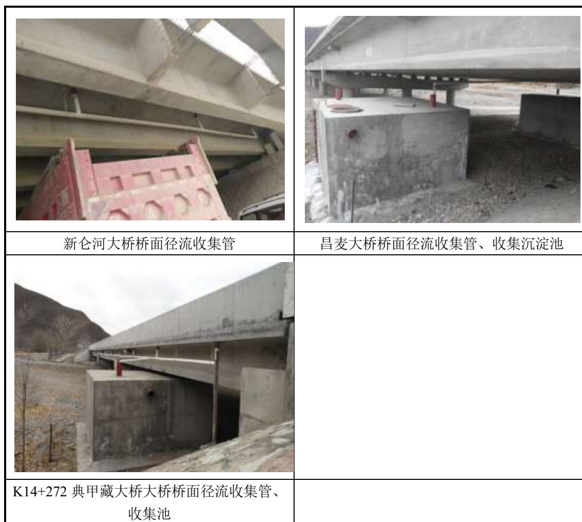
图 6.5-1 桥面径流收集系统
