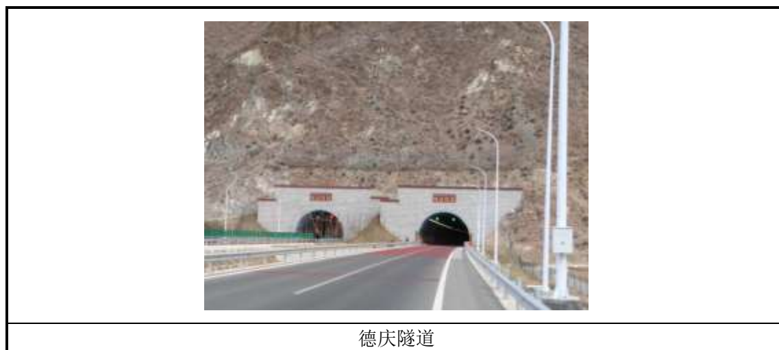
图 5.2-6 隧道上方植被恢复情况
