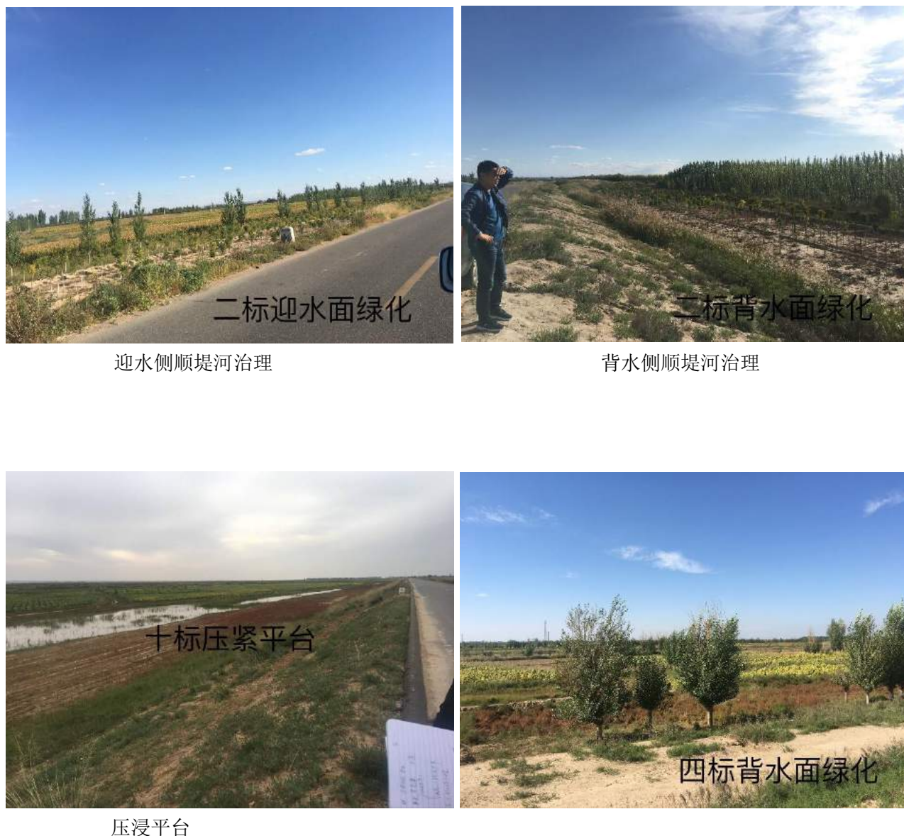
图 3.1-2 本工程主体工程照片
