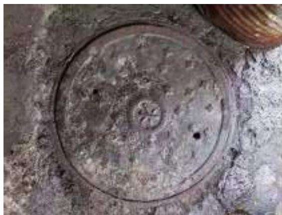
图 2-4 化粪池现场照片
