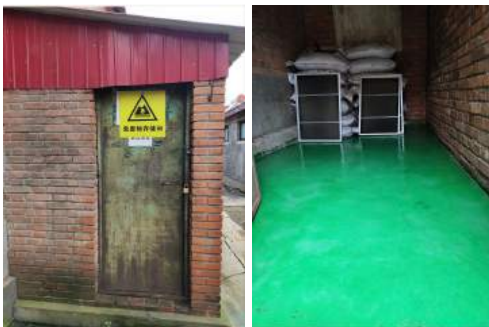
图 2-6 危废暂存间现场照片
