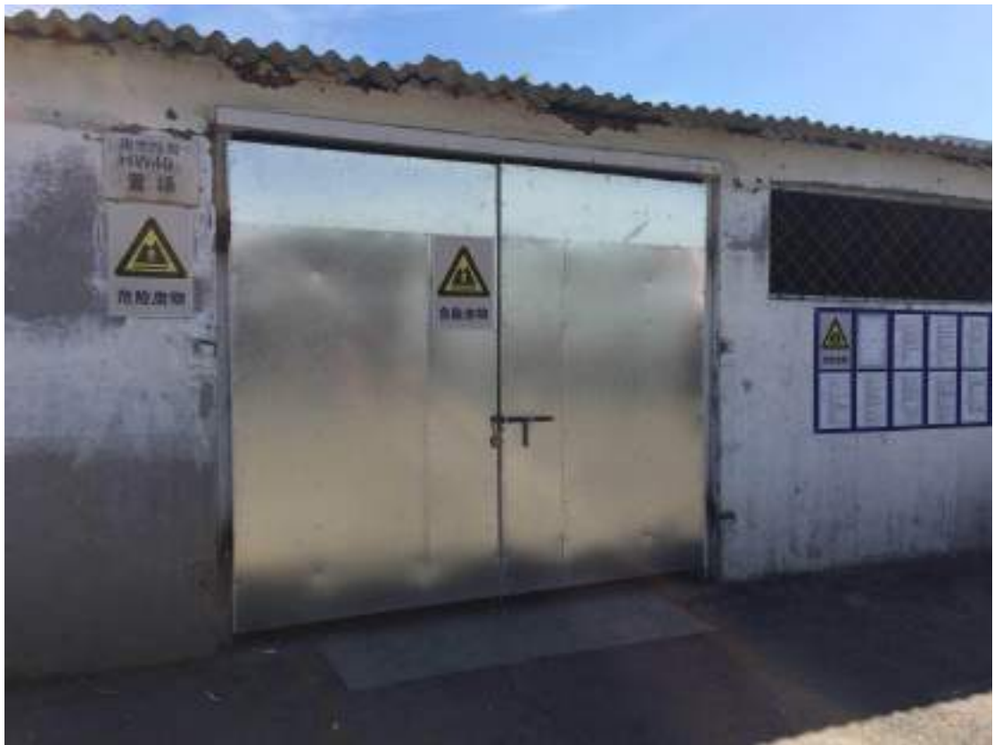
危险废物暂存间
