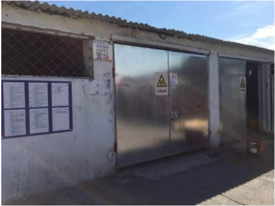
危险废物暂存间
